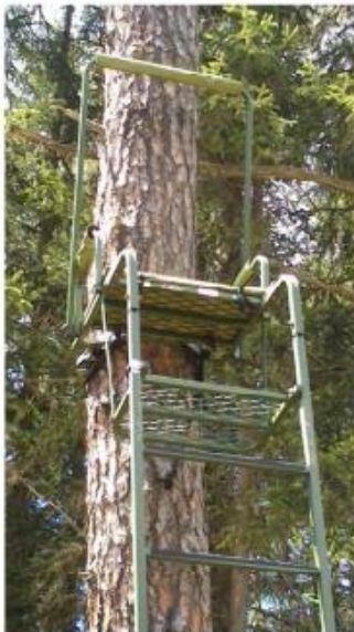
Einfache Jagdeinrichtung aus Metall (Ansitzeleiter), Befestigung mit Zurrgurten am Baum, leicht und flexibel
